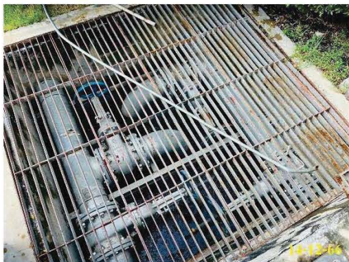
บ่อพักน้ำสุดท้าย พร้อมตะแกรงดักขยะก่อนระบายออกนอกโครงการ
