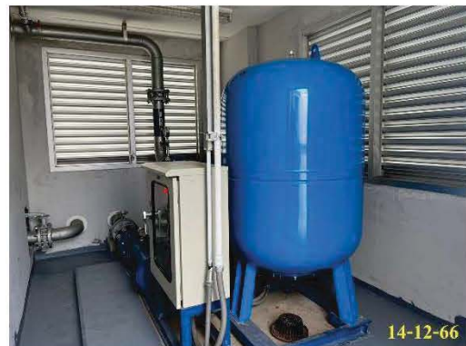
ถังเก็บน้ำชั้นดาดฟ้า และเครื่องปั๊มน้ำ อาคาร D
