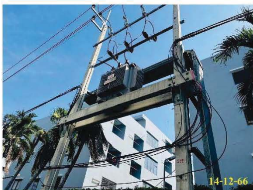
หม้อแปลงไฟฟ้า ขนาด 630 KVA พร้อมตู้ควบคุมไฟฟ้าอาคาร A
